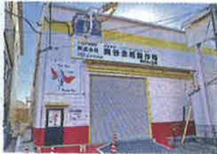
奥谷金網製作所は昨年12月、経年劣化補修と暑熱対策のため、明石第1工場の外壁・屋根に高耐久・断熱コーテ
